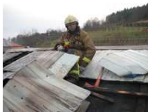
Požar građevinskog objekta Svetičko Hrašće
