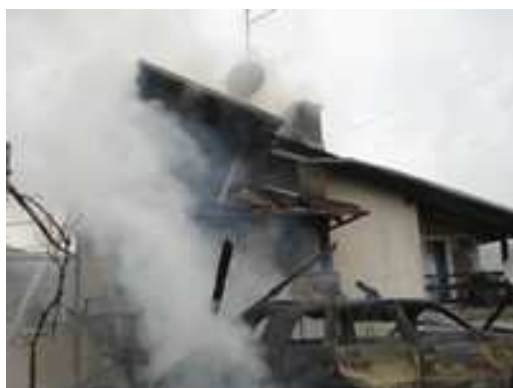
Požar građevinskog objekta Svetičko Hrašće
