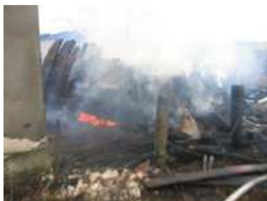
Požar kuće Vodostaj
