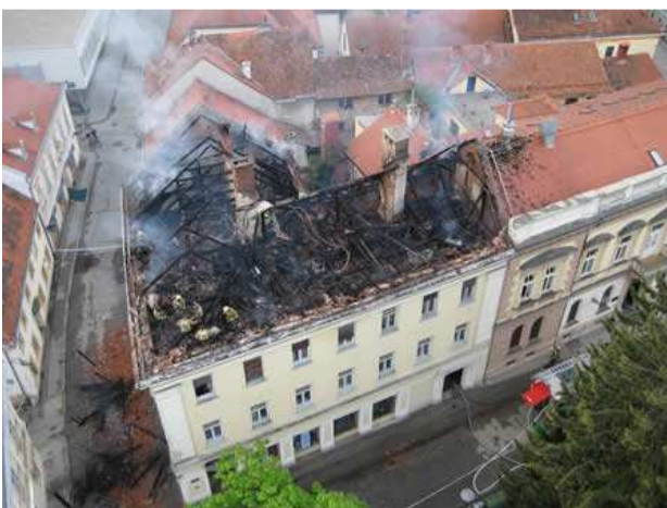
Požar krovišta A.Cesarca
