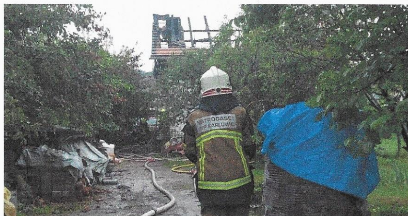
Slika: Požar kuće na Borlinu, svibanj 2024.
