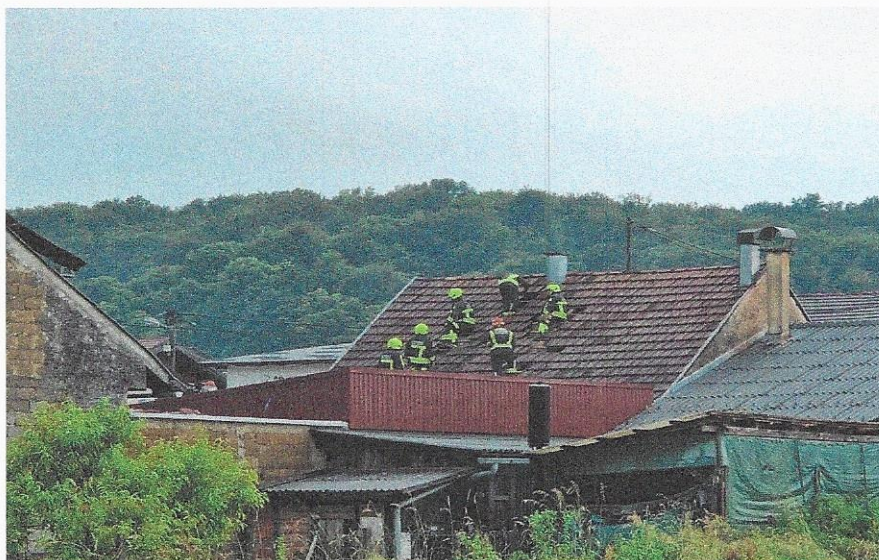
Slika: Sanacija krova na stambenom objektu nakon nevremena, svibanj 2024. godine
