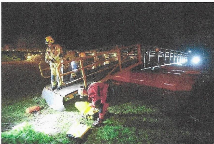
Slika: Sidrenje pontonskog mosta u suradnji s HGSS Stanica Karlovac
