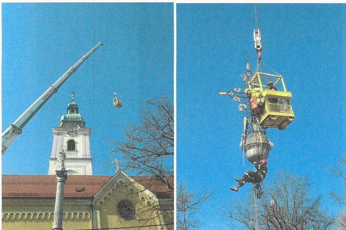
Slika: Sanacija objekata nakon potresa, skidanje križa sa crkve Presvetog Trojstva
