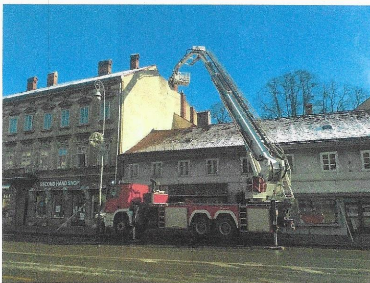
Slika: Sanacija objekata nakon potresa na području grada Karlovca
