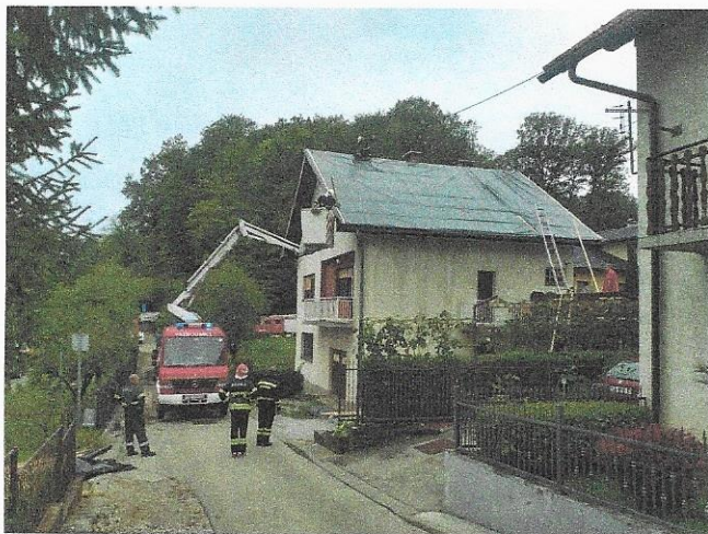
Sanacija oštećenih krovova nakon nevremena sa jakom tučom
