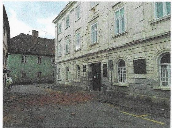
Karlovac, sanacija posljedica potresa
